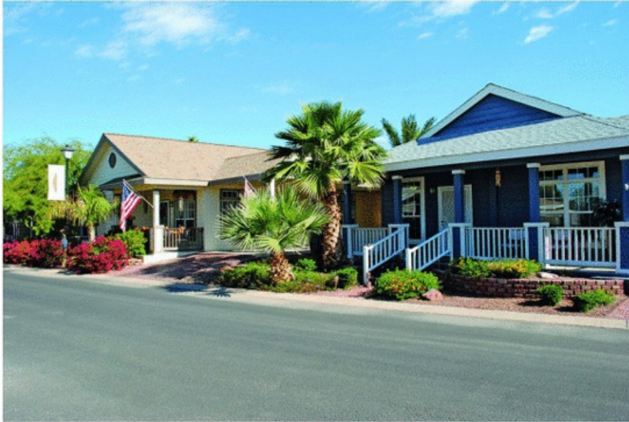
Casa del Sol East - Glendale, AZ
